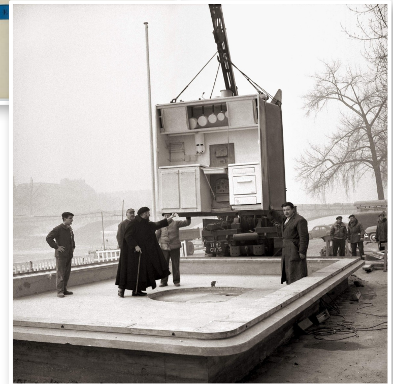
Montage d'un prototype de la Maison des Jours Meilleurs, dessiné par Jean Prouvé, en 1956
