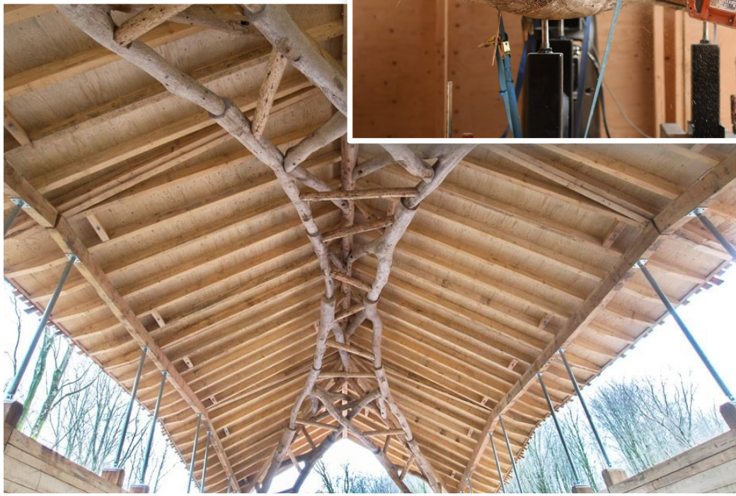
« Wood Chip Barn », un projet réalisé en 2016 par les étudiants du programme Design+Make de la AA School en Angleterre
